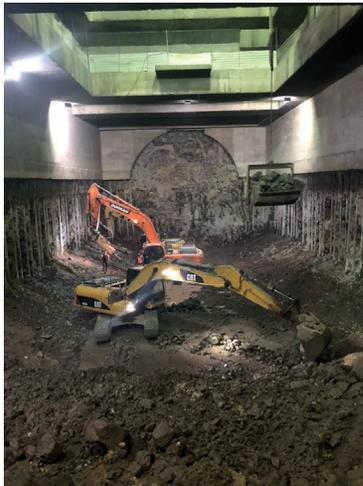
Figura 13.- Vista general, excavación a cota de contrabóveda.
