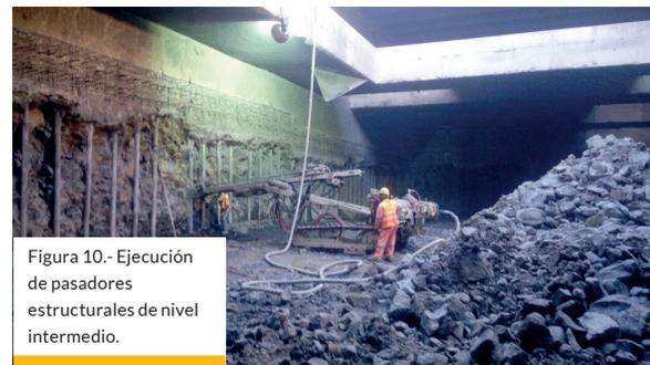
Figura 10.- Ejecución de pasadores estructurales de nivel intermedio.
