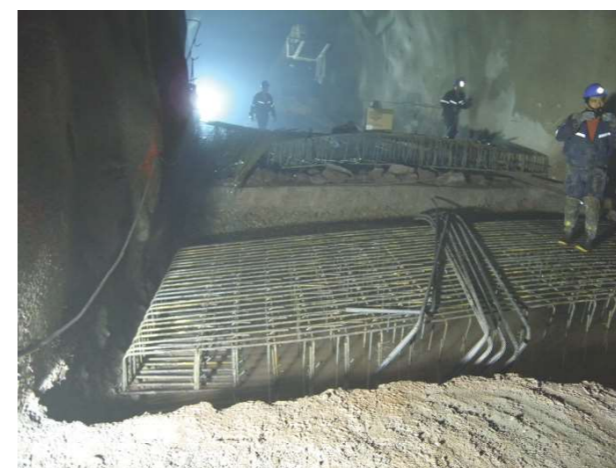
Rehabilitation PH La Confluencia, Chile
