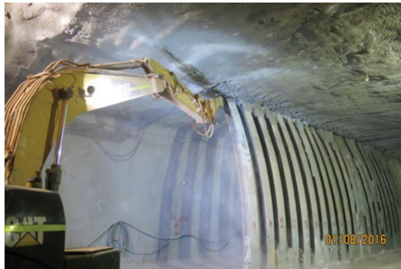
Figura 15. Demolición del sostenimiento provisional.
