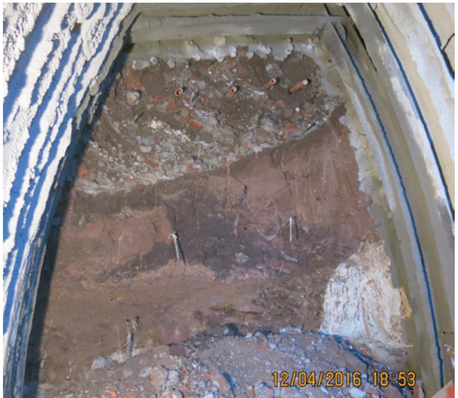
Figura 13. Fugas de la inyección en el contacto del Relleno Antrópico con la Formación Abanico.
