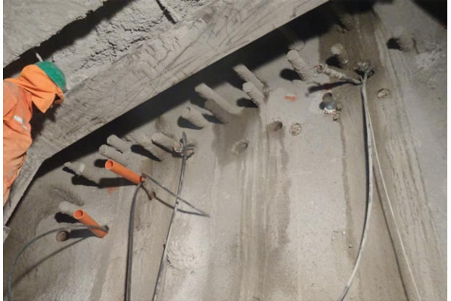
Figura 12- Realización de inyecciones desde dentro del túnel.
