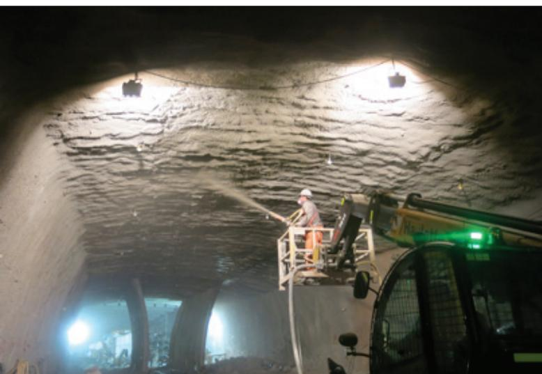
Figura 16.- Ejecución de segunda capa de sostenimiento definitivo.
