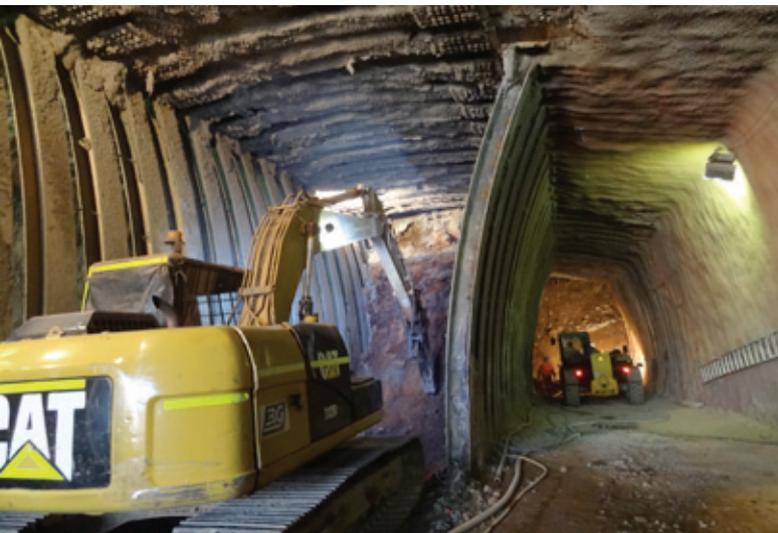
Figura 14. Proceso de excavación del túnel.
