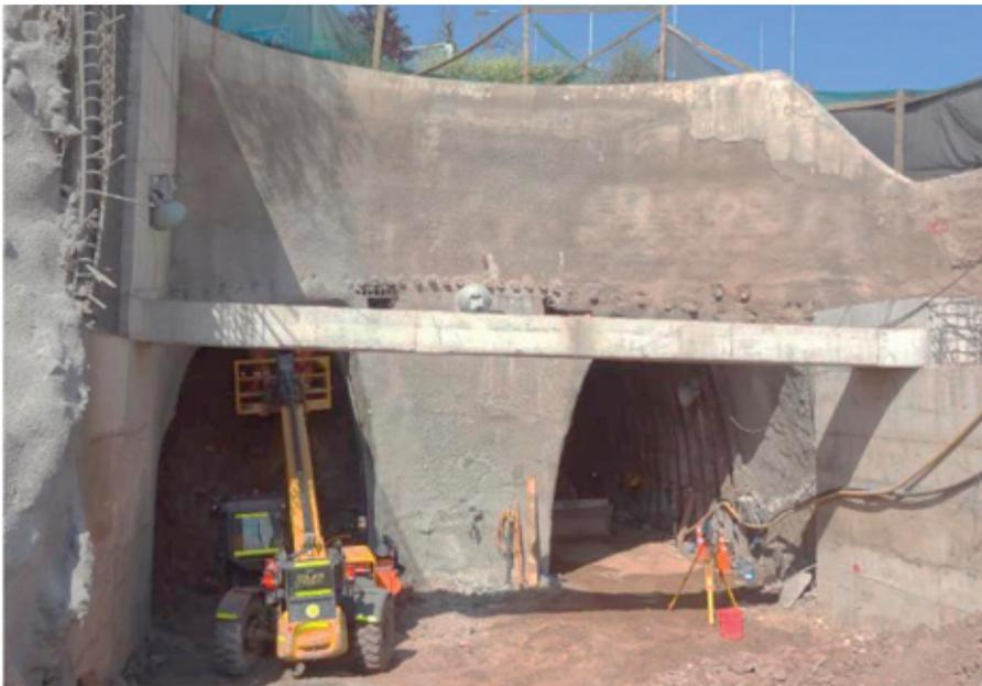
Figura 10. Vista del emboquille donde se distinguen las secciones de excavación A y B.
