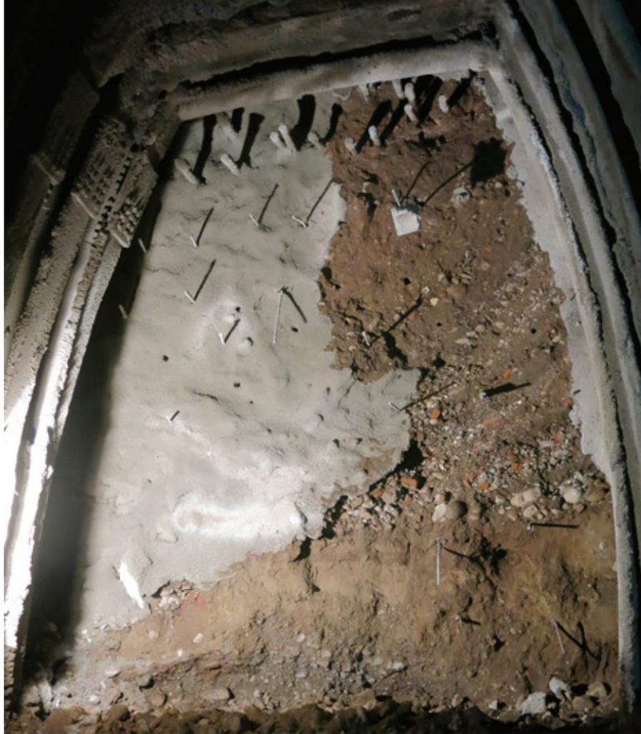
Figura 5.- Rellenos antrópicos en el frente de excavación del túnel
