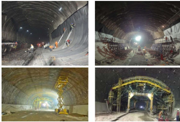
Fotografías 10, 11, 12 y 13. Secuencia de construcción para el revestimiento.
