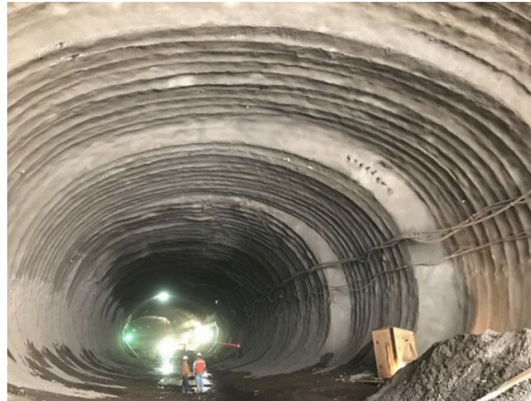
Fotografía 9. Transición entre las secciones de cuatro carriles y las de cinco carriles.
