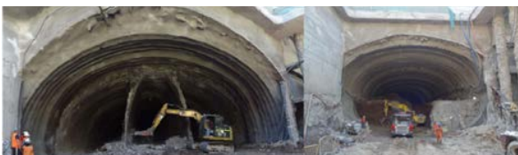
Fotografías 7 y 8. Secuencia de construcción para la sección de cinco carriles.
