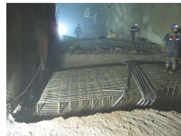
Rehabilitación CH La Confluencia, Chile
