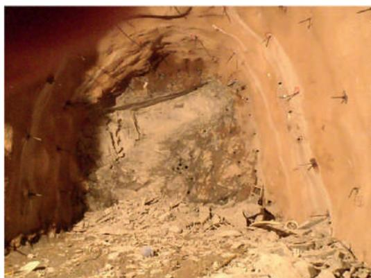
Figura 3: Estallido de roca en el frente de excavación del túnel Conducción.
