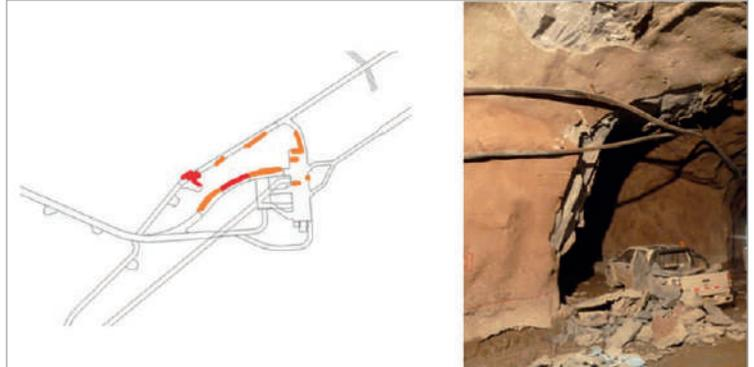
Figura 2: Zonas afectadas por los estallidos ocurridos el 21/03/2012 y fotografía de los daños producidos en el túnel by-pass.
