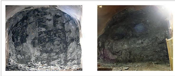
Figure 14: Frente del túnel conducción después de eventos de estallido de rocas.
