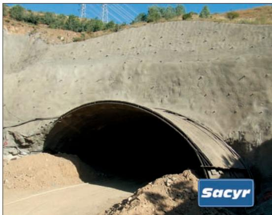
[Foto 4].- Talud frontal esviado, en el Portal Norte, para minimizar la altura de los taludes.
