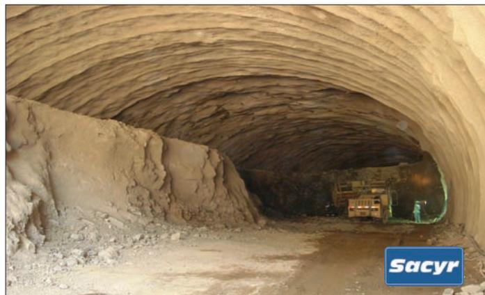
[Fotos 7 y 8].- Dos momentos de la excavación, en dos fases, de la destroza. Obsérvese las imponentes dimensiones de la excavación.
