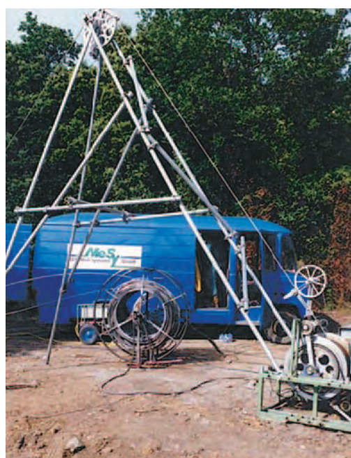
FOTOGRAFÍA 4. Emplazamiento de sondeo ST-21 realizado en Guadarrama.
