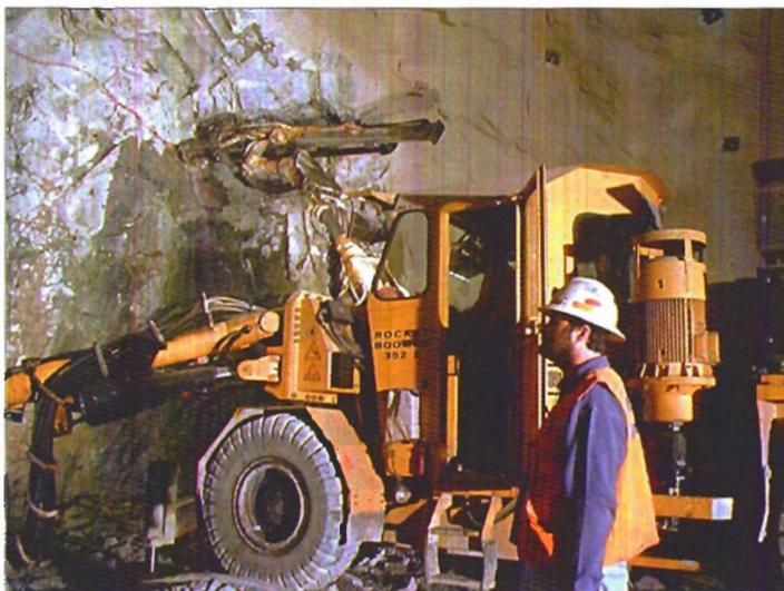
Foto 3.- Perforación en el frente Oriente del Túnel de Lo Prado II.
