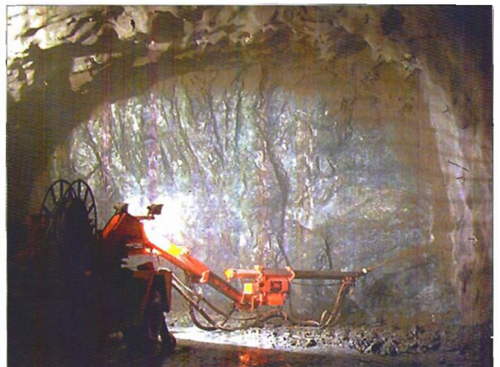
Foto 4.- Gunitado en el frente oriental del Túnel de Lo Prado II.
