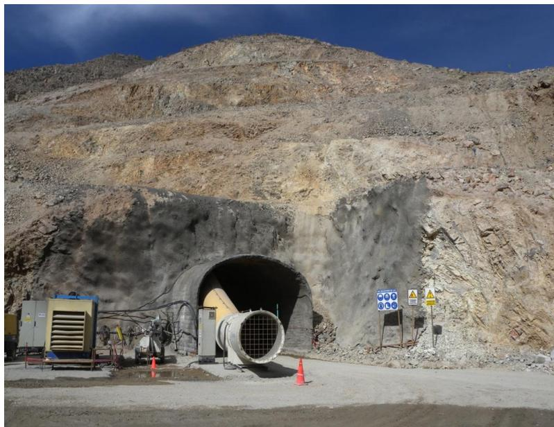
Fotografía 2 – Portal de entrada (lado Chancadora) del túnel de transporte principal
