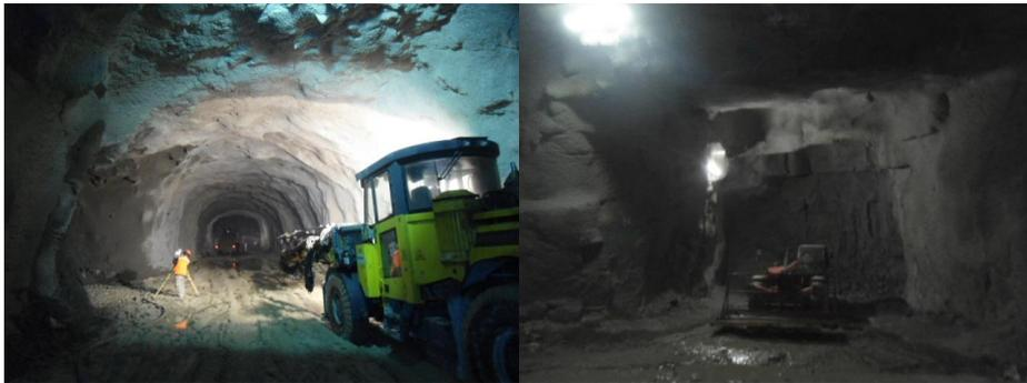
Fotografía 7 y 8 – Construcción de los sobreanchos del túnel
