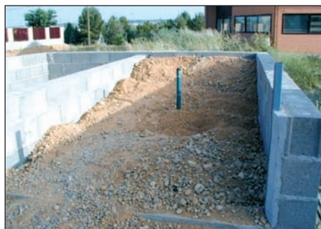
■ [Figura 2] .- Relleno del estanque piloto.
