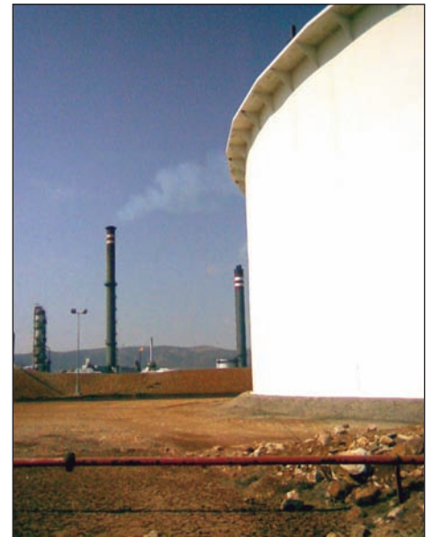
■ [Figura 6].- Tanque y cubeto.
