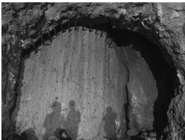
Fotografía 2. Micropilotes colocados como parte del sostenimiento especial para cavernas aplicado en el frente 4 de excavación del Túnel 1.
