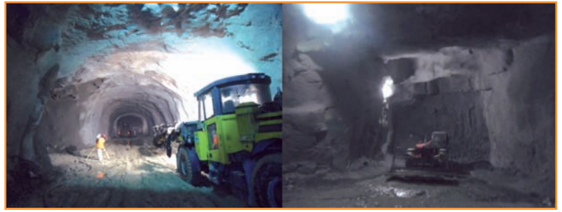
■ [Fotos 7 y 8].- Construcción de los sobreeanchos del túnel.
