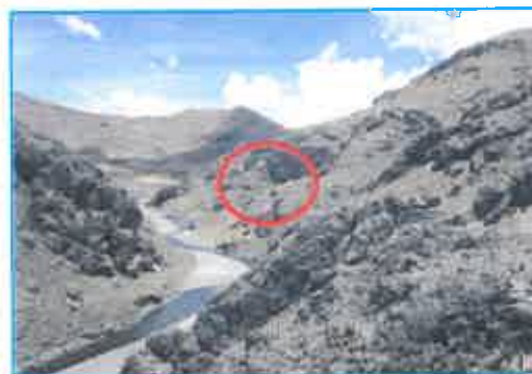
■ [Foto 1].- Inicio del túnel de Pucará en la cerrada Angostura sobre el río Apurímac.
