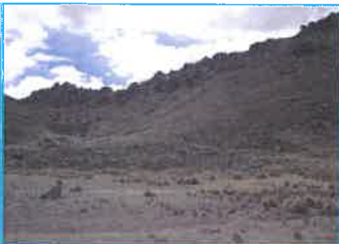
[Foto 7].- Portal de salida del túnel Transandino.
