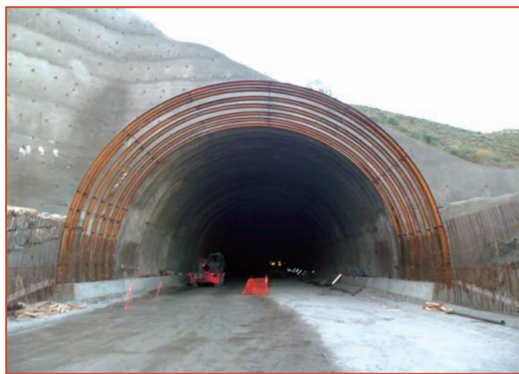
[Foto E] .- Estructura de falso túnel diseñada mediante cerchas.
