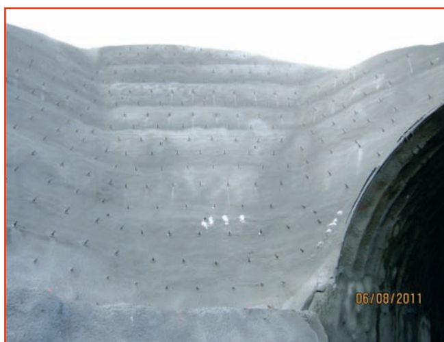
■ [Foto D] .- Vista del cartabón izquierdo ejecutado, en el talud de emboquille.
