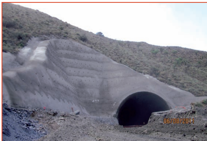
■ [Foto C].- Aspecto del emboquille una vez ejecutada la excavación.
